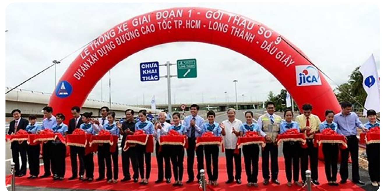
Đường cao tốc Bắc Nam - Đoạn TP. HCM - Long Thành - Dầu Giây
