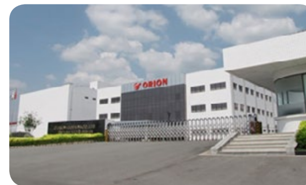
Nhà máy bánh kẹo Orion - Bình Dương
