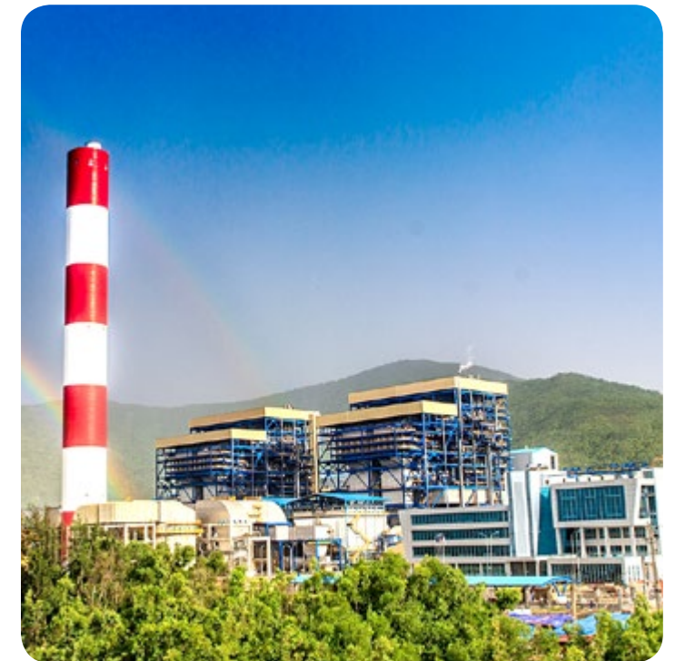
Nhà máy nhiệt điện Vũng Áng 1 - Hà Tĩnh
