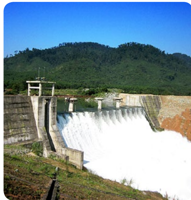
Nhà máy thủy điện Đak Mi 4 - Tỉnh Quảng Nam
