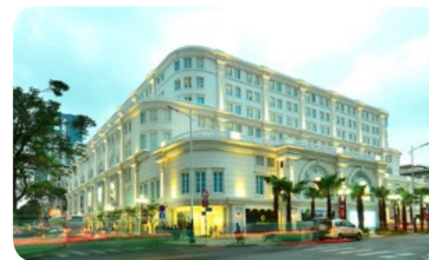
Dự án Vincom Center A - Quận 1, TP. HCM
