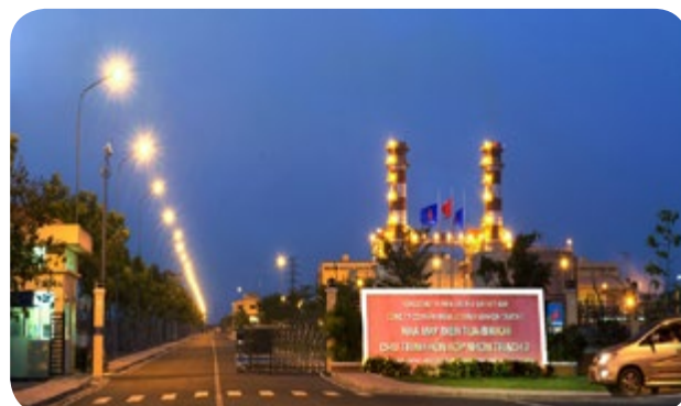
Nhà máy nhiệt điện Nhơn Trạch 2 - Đồng Nai
